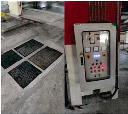
ภาพถ่ายที่ 2.2-13 ระบบบำบัดน้ำเสียขั้นต้นได้สถานี
